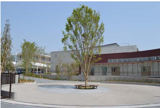
【西棟・実習棟】
