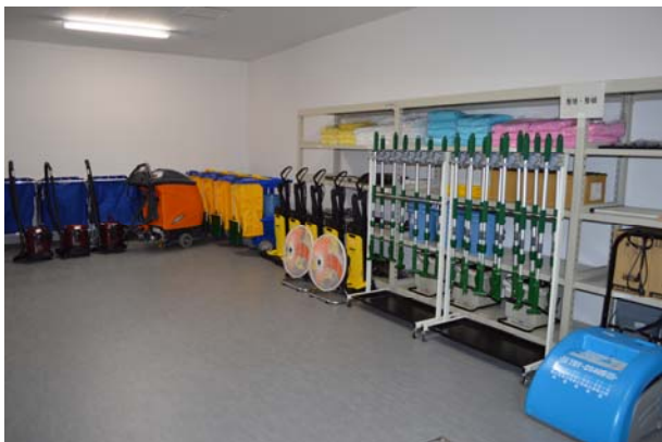
【ビルメンテナンス倉庫】
